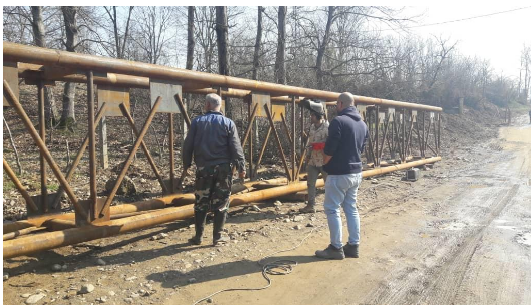
خرپای مربوط به عبور لوله گاز از شهرک گلخانه ای دیسام
